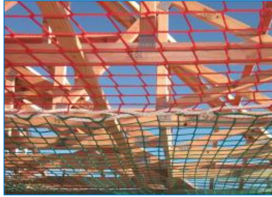
Şekil 21: Ağların birleştirme ipi ile bir araya getirilmesi
