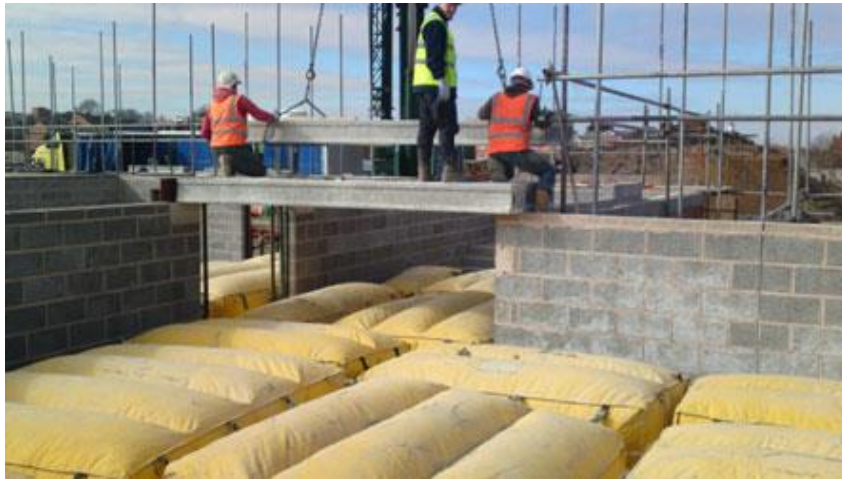
Şekil 2: Düşmeye karşı hava yastıklarının kullanımı
