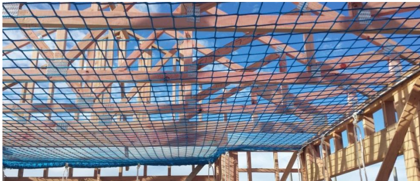
Şekil 15: Çatı işinde güvenlik ağı kullanımı
